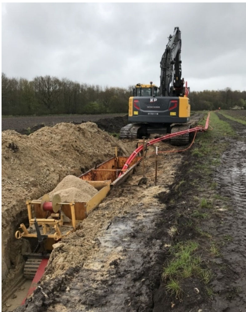
Figur 2. Nedlægning af 60 kV-kabler i tæt trekant ved hjælp af gravekasse.
