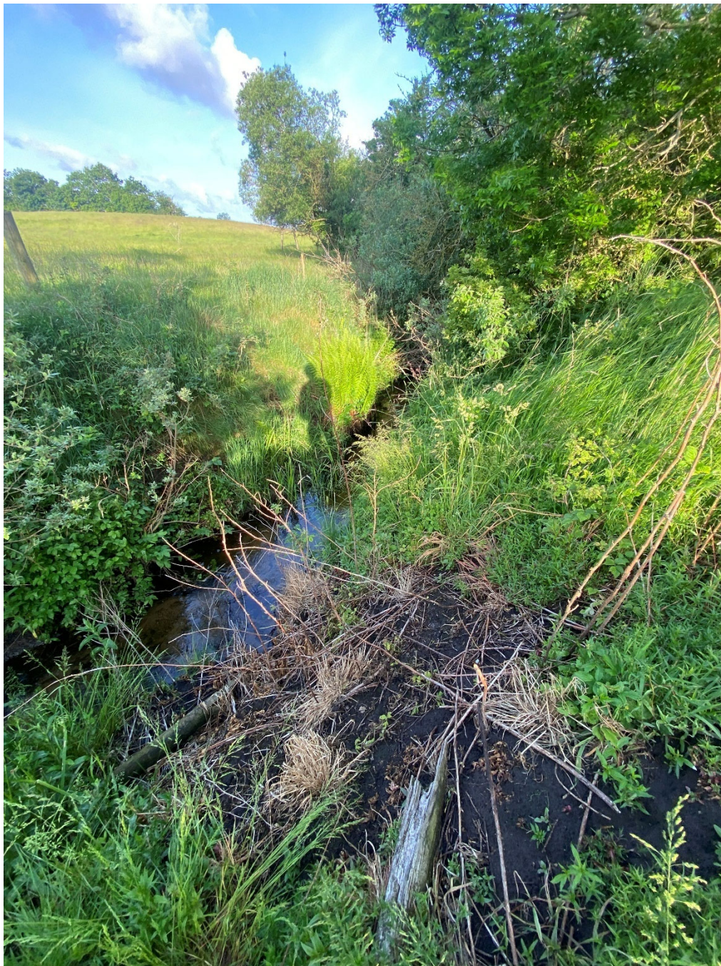
Figur 28. Lygtebækken, hvor traceet krydser med styret underboring.
